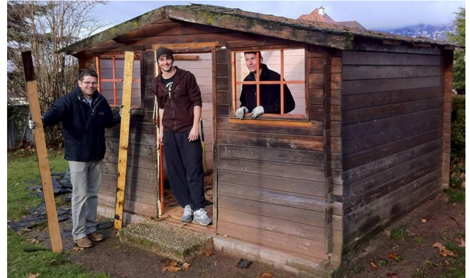
Photo 3 : Démolition du cabanon le 28.01.2012 avec John Linder, Dominique Charpillot et Marc Soldini.
