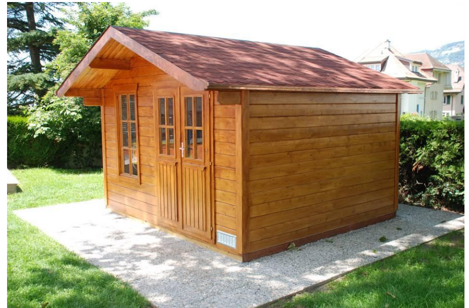
Photo 4 : Nouvelle construction après quelque 150 heures à 22 membres-bénévoles
