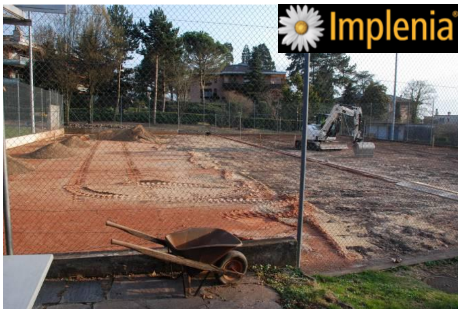
Photo 5 : Evacuation de la terre battue et pose d'un enrobé drainant par Implenia.
