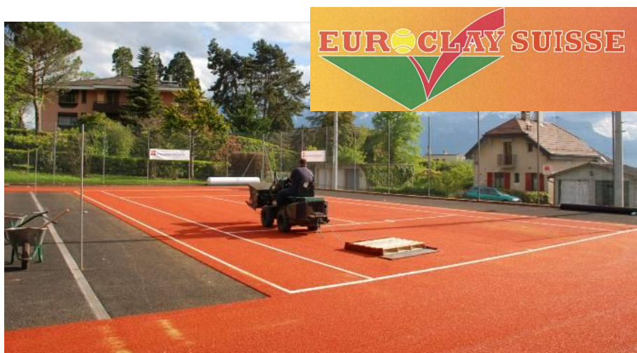
Photo 6 : Pose des tapis et des 22 tonnes de sables par Euroclay Suisse Sàrl.
